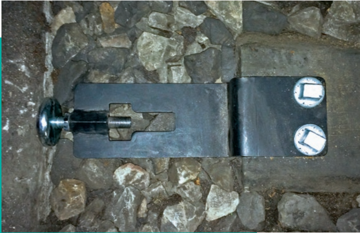
Montage Holzschwelle – mit Bohrung
